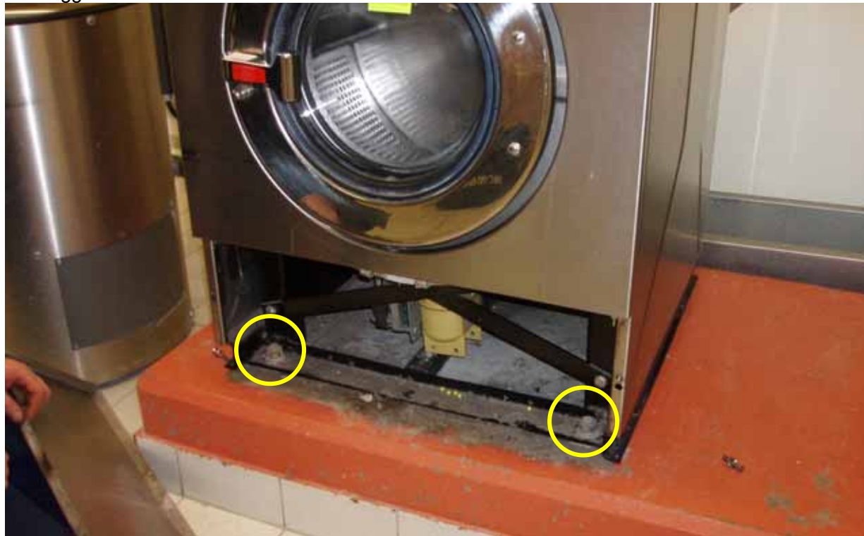
Figur 7. Tvättmaskin bultad till betongfundament.
